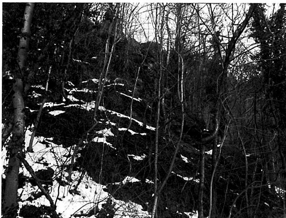
FOTO 2: affioramento interessato dal crollo. Vista da Ovest
